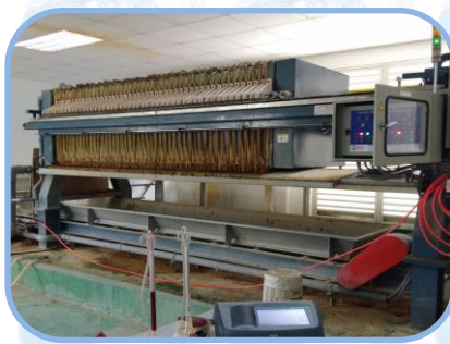
Lắp trên băng tải
